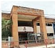
El nuevo módulo educativo se edificará en la unidad Elvira Frías
