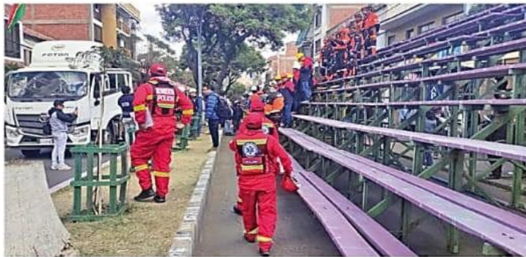
GRADERÍAS. La infraestructura habilitada para el público de la festividad de hoy y mañana en la avenida Herraño Sites.
