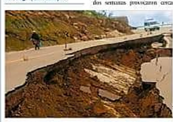
TRAMO DE LA CARRETERA QUE UNE COCHABAMBA CON TERCERO.
