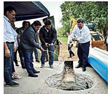
El pozo se perfora en la Urbanización Fabiola, del distrito 2
