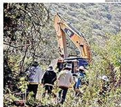
Maquinaria trabaja para instalar la planta en Molle Molle.
