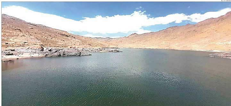
Uno de los reservorios del sistema de agua Kari Kari.
